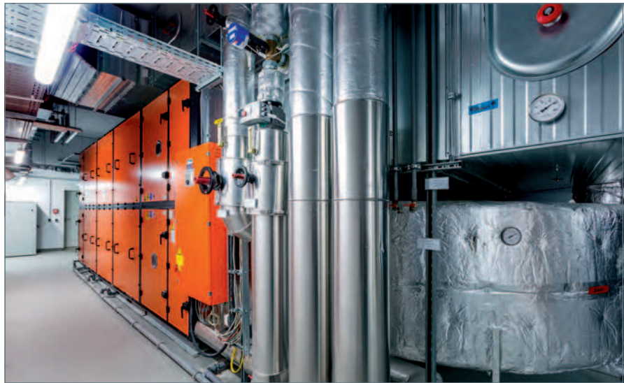
■ Lüftungsanlage mit Zu- und Abluft
