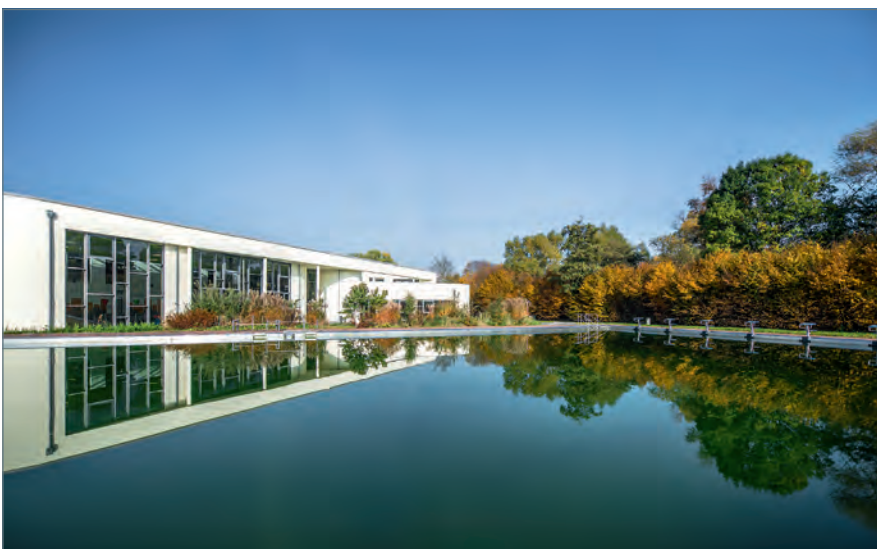
■ Blick vom bestehenden Freibad auf die Badehalle mit Kinderbecken
