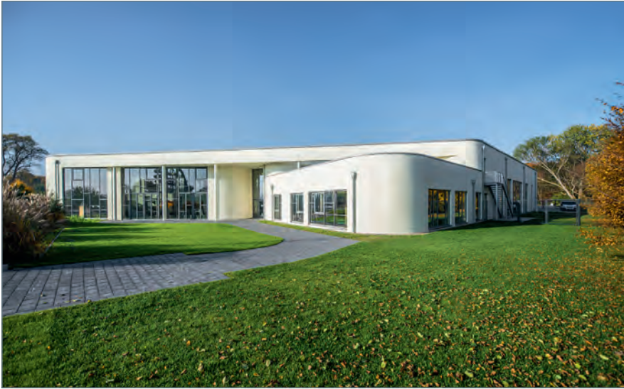
■ Der Neubau von Osten
